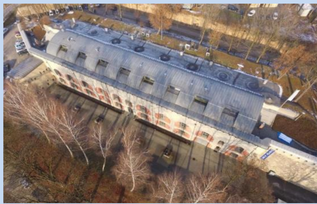
Fig.2. Fort Węgrzce (UAV image).
